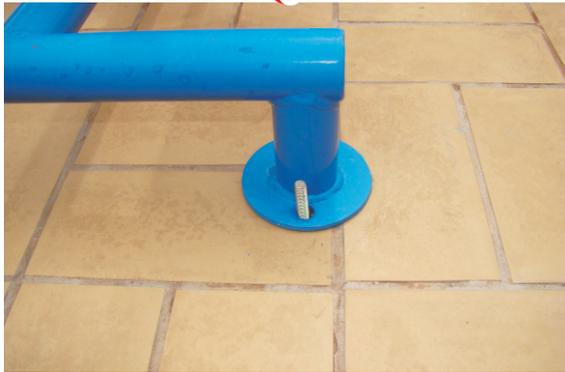
Posicionamento do equipamento mediante demarcação e perfuração.
