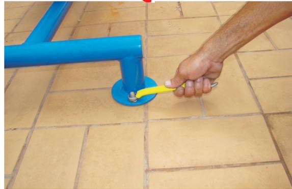
Fixação da base do equipamento ao chão por meio de parabout.
