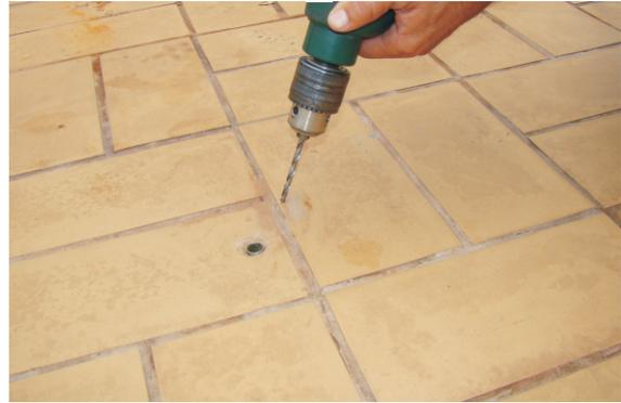
Perfuração de 6 cm para fixação do equipamento por paraboaut.
